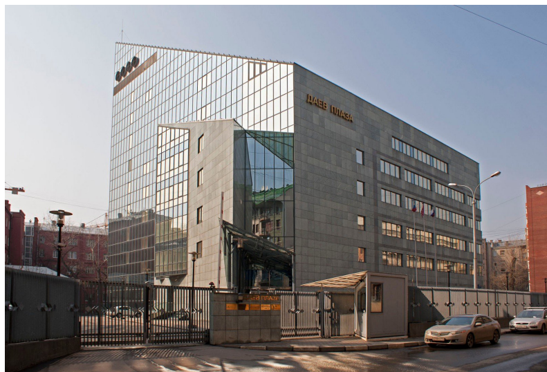
Ил. 1. Здание «Даев-Плаза», Москва (бывш. здание Уникомбанка, «Моспроект-2» имени М.В. Посохина, мастерская № 2, Вл. Колосницин, Д. Солопов и др., 1994–1996, Даев пер., 20). Источник: https://madeinfuture.ru/zdanie-«unikombanka»-v-daevom-pereulke-daev-plaza . Fig. 1. The Daev-Plaza Building, Moscow (former building of Unikombank, M.V. Posokhin “Mosproject-2”, Workshop No. 2, V. Kolosnitsyn, D. Solopov et al., 1994–1996, 20 Daev Lane). Source: https://madeinfuture.ru/zdanie-«unikombanka»-v-daevom-pereulke-daev-plaza .
