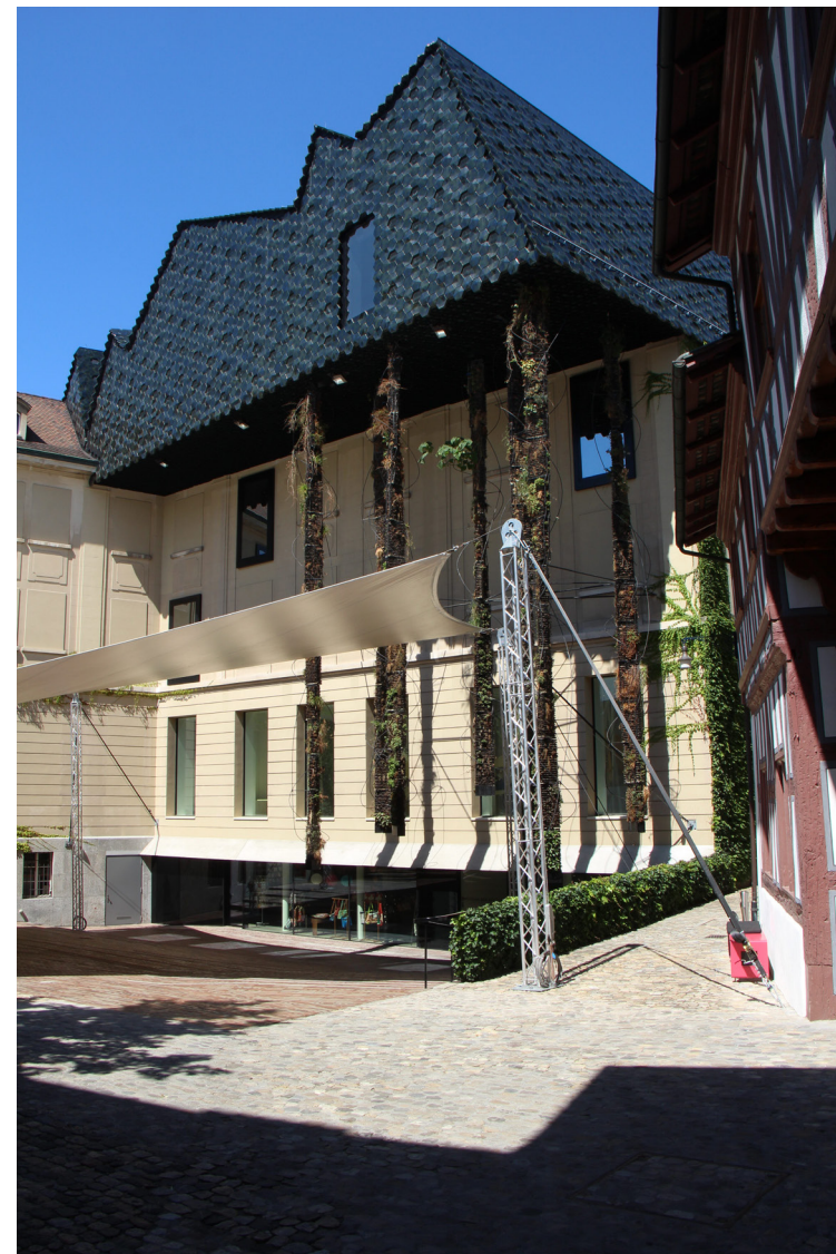
Ил. 3. Музей культур Базеля, Швейцария. 2008–2011. Архитекторы Жак Херцог и Пьер де Мёрон. Фото: М. В. Дуцев Fig. 3. The Museum of Cultures, Basel, Switzerland. 2008–2011. Herzog & de Meuron. Photo: M. V. Dutsev
